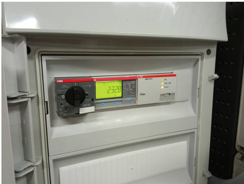
Rysunek 1. Licznik energii z możliwością zdalnego odczytu
